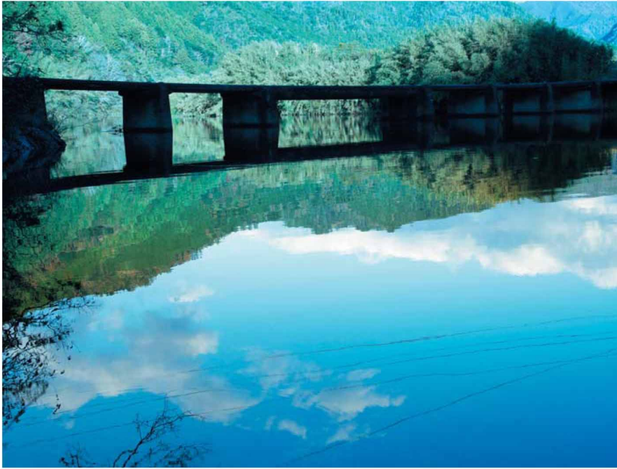
「一斗俵沈下橋」(いっとうひょう)昭和10年に建設され、四万十川に現存する沈下橋の中で最も古い沈下橋として国の登録有形文化財に指定されている。
