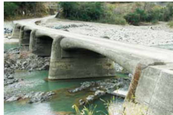
「上岡沈下橋」(かみおか)正式名称は「向山橋」。床板の下部が曲線を描いており、橋脚も丸みを帯びていて、ユニークなデザインで大変美しい沈下橋。
