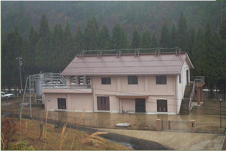
上田所浄水場
