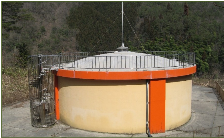
上田所配水池
